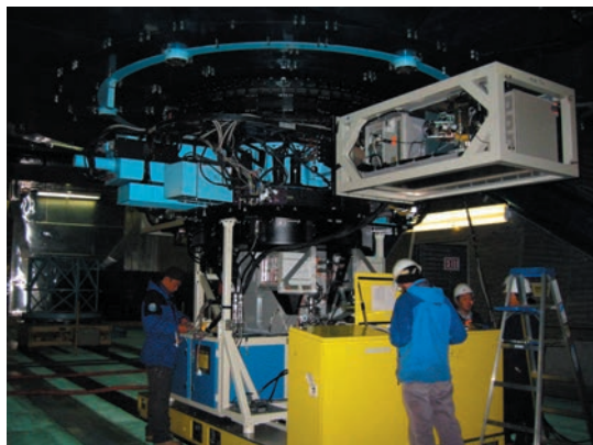
写真 4. 観測装置の取付け作業風景
