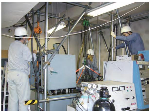
やぐらの組立が終わって、いよいよ電源ユニットを引き上げる作業に入ったところ。チェーンブロックの取り付けがある梁は荷重に耐えてくれるか、足場の柱の強度は大丈夫か、緊張する作業である。すぐ横にはスパッタ装置が置いてある。
