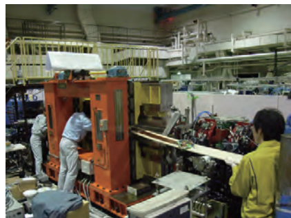
図 5 設置作業の様子
